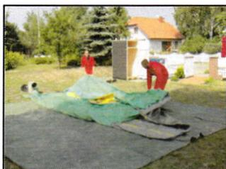
Aufstellfläche auf spitze Gegenstände prüfen - Unterlegplane ausbreiten - Modul drauflegen und auseinanderrollen. Einen Lufteinfüllschlauch mit dem Gebläse verbinden, wenn vorhanden den 2. Lufteinfüllschlauch schließen.
